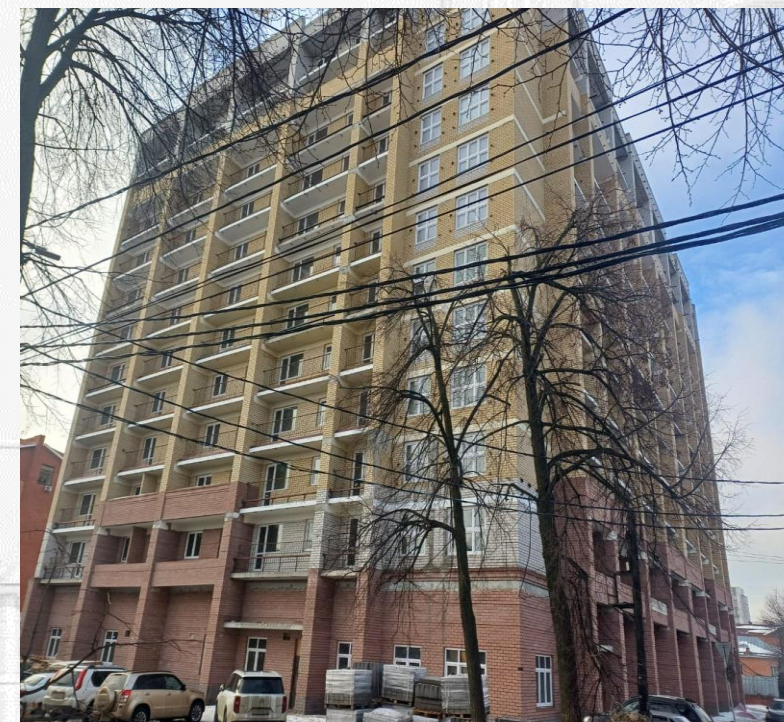
проблемный объект - по ул. Красноармейская, 67 (ООО «СК Атриум»)
