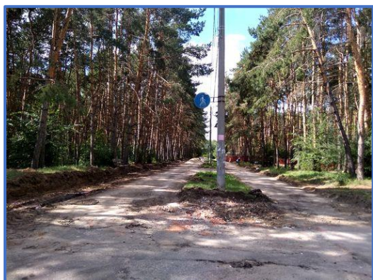
Парк им. маршала Г.К. Жукова (до реконструкции)
